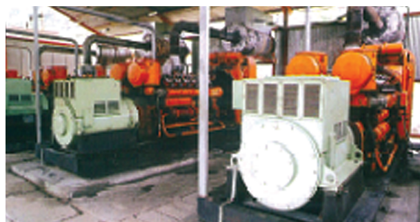
Generadores eléctricos operados con MMC: Jincheng Anthracite Mining Group en China.
